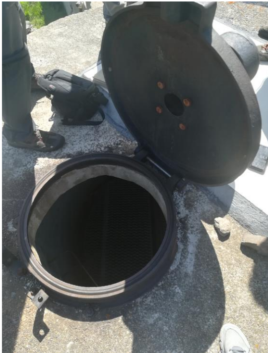
Illustration 15 : Ouvrage de captage
